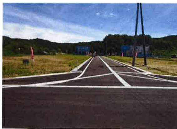
敷地前面道路
