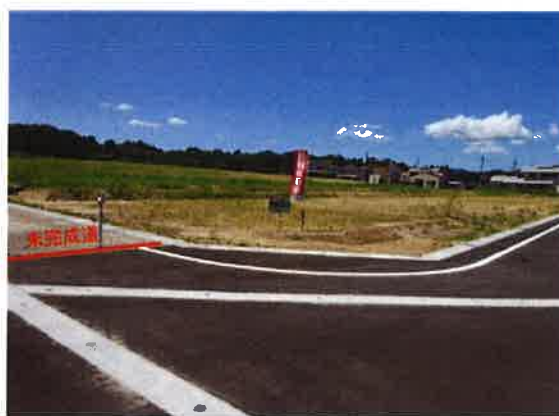
敷地前面道路
